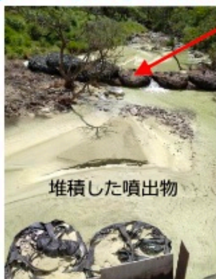
堆積した噴出物 取水堰上から見た 上流側
