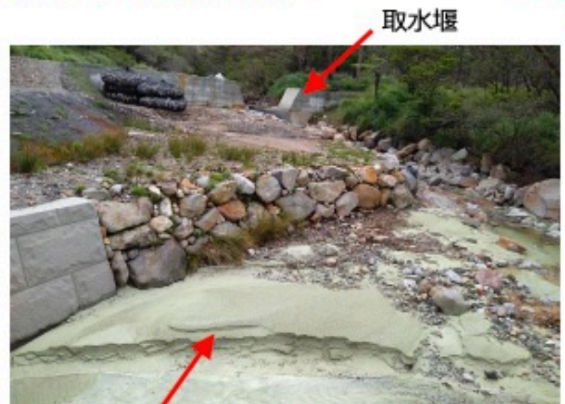
取水堰下流からみた川の状況
