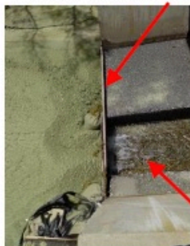
取水堰上部の状況
